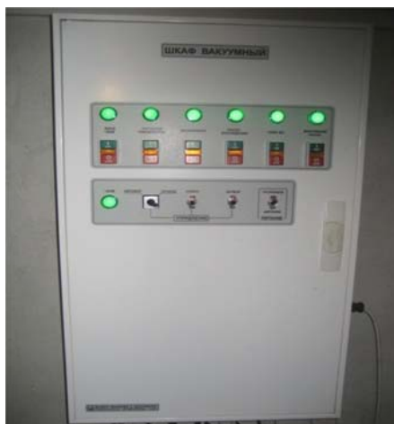
Рис. 181. Шкаф с управляющей электроникой системы вакуумирования трубы телескопа
