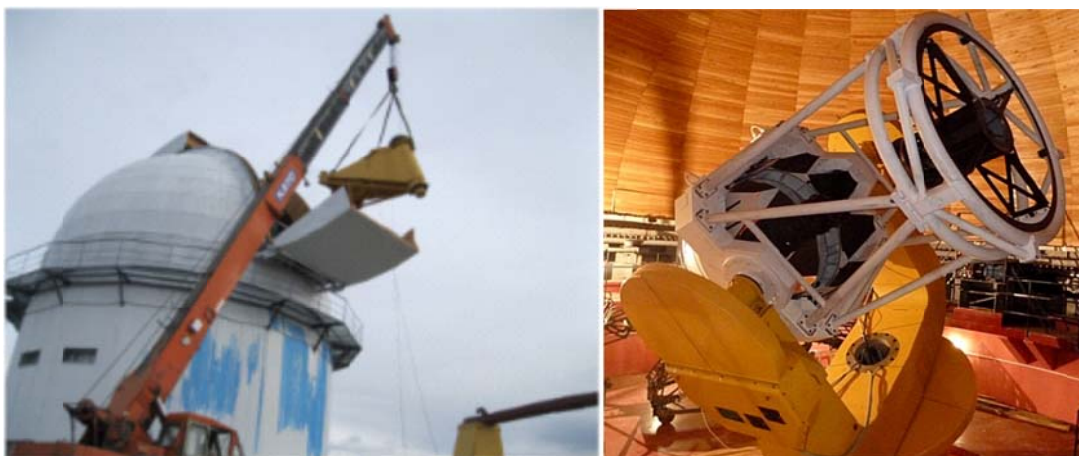
Рис. 202. Процесс монтажа АЗТ-33 ВМ (левая панель, подъем корпуса часовой оси) и общий вид телескопа после завершения сборки
