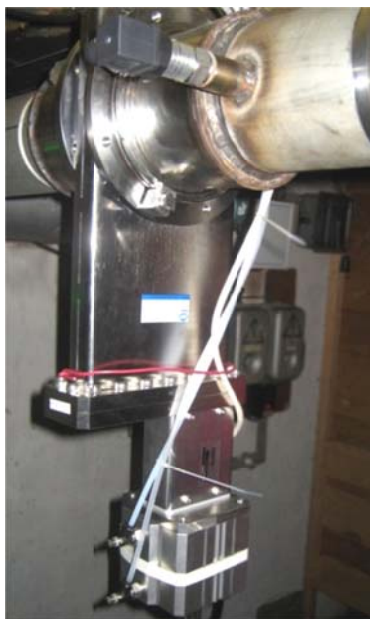
Рис. 178. Вакуумный затвор, блокирующий воздушный поток во время внештатных ситуаций
