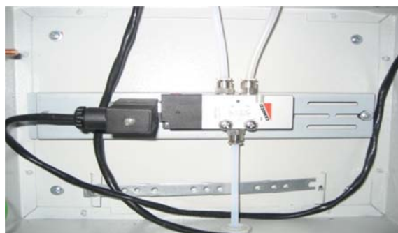
Рис. 179. Электропневматический клапан, управляющий работой вакуумного затвора
